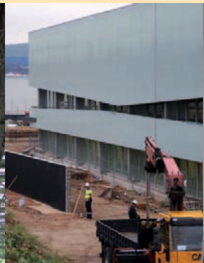
Entorno La Llana: El entorno de La Llana será la última obra en finalizar
