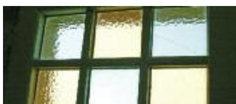
Detall dels vidres de les finestres
