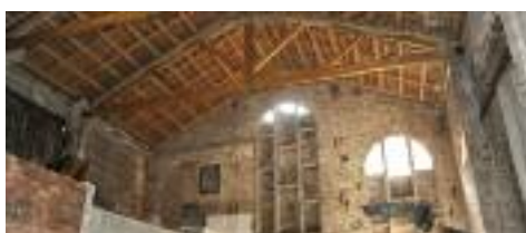
Imatge del sostre des de l'interior
