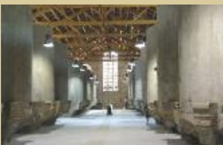
A la primera planta de l'edifici s'han mantingut les tines
