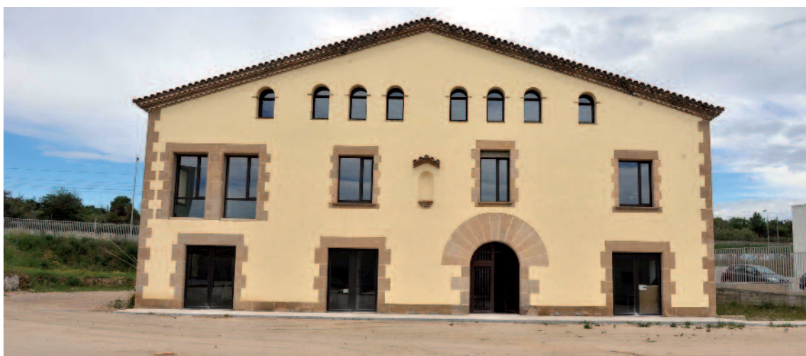
La façana de la Masia, un cop rehabilitada
