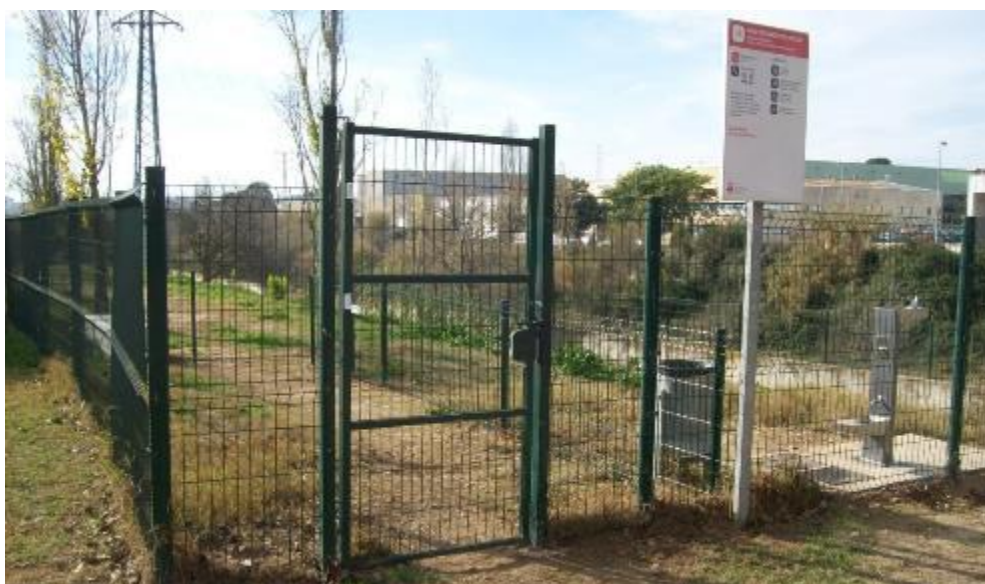
Tanca de la zona d'esbarjo de la C1413a-Ctra. de Terrassa. Tanca de malla plegada d'1,80m d'alçada
