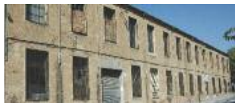
Façana frontal de la nau
